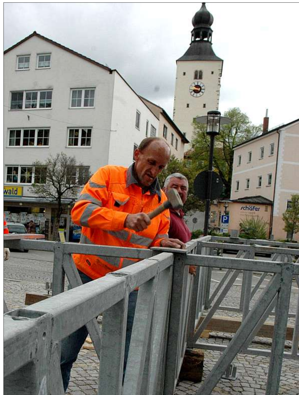
Hämmern für das größte Volksmusik-Festival Bayerns. Auch im Bauhof der Stadt Regen dreht sich seit einigen Tagen (fast) alles um das drumherum. Am kommenden Donnerstag, 20. Mai, wird es eröffnet; und bis dahin muss die Stadt herausgeputzt sein – die Bühne am Stadtplatz ist gestern schon aufgebaut worden. – Foto: M. Lukaschik
