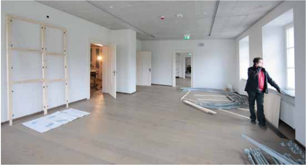
▲ Hier ist noch Baustelle: Roland Pongratz im künftigen Ausstellungsraum zum Bahnbau im Grenzbahnhof Bayerisch Eisenstein. [Fotos: Herbert Pöhl, 2013]
